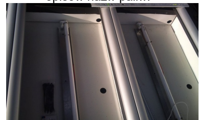
Sprawdzenie całego systemu pylonu cenowego led.
