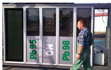
Montaż pleksy z opisami statycznymi nazw paliw.
